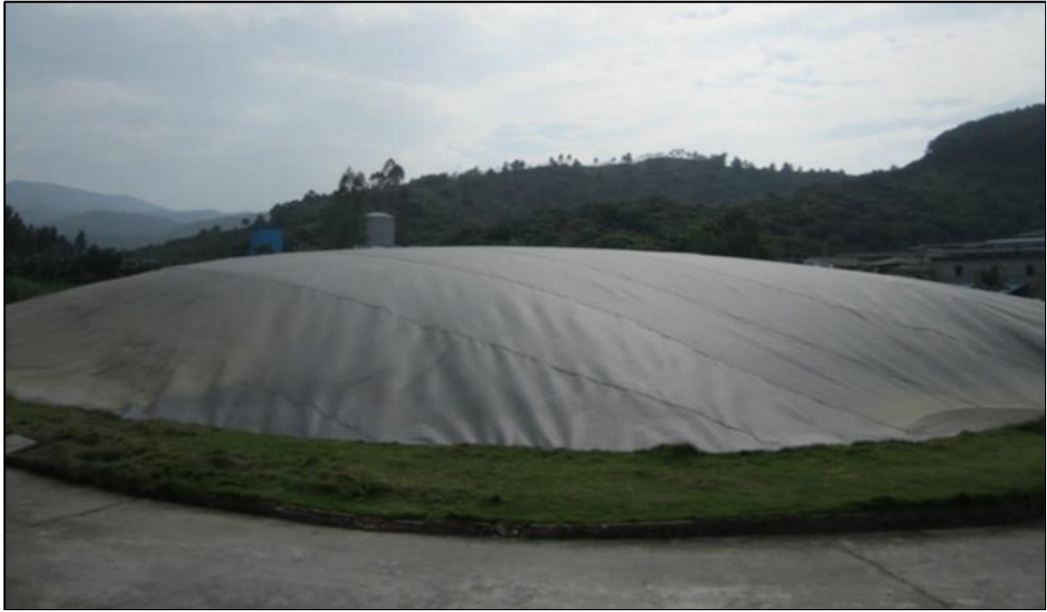
图 5.2-4 建成后的黑膜沼气池示意图
