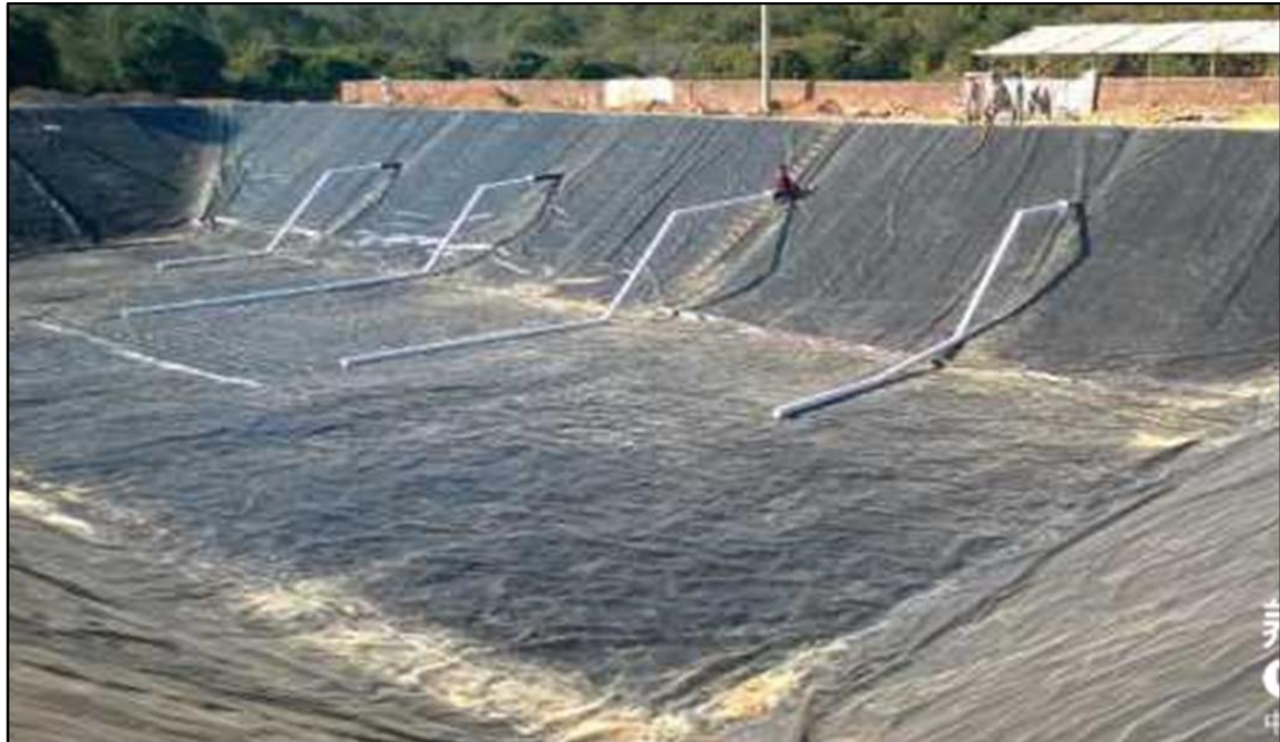
图 5.2-3 黑膜沼气池内部示意图
