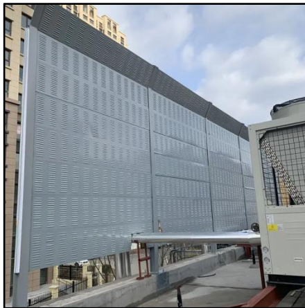
室外机集中区四周设置隔声板图例
