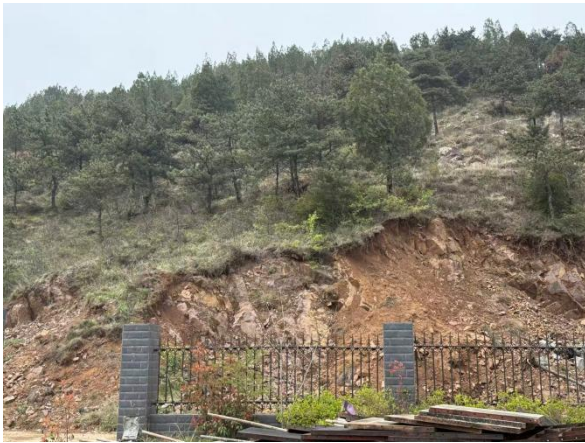
项目西侧现状
